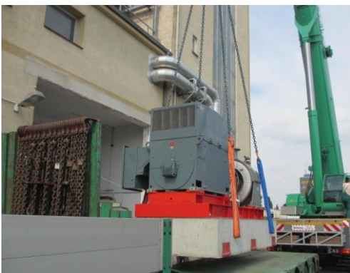
Abbildung 4: Demontage ORC-Turbine und Generator (Quelle: Th. Arens Anlagenbau GmbH)
