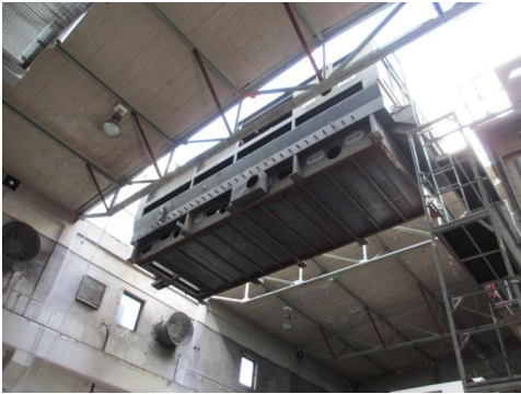
Abbildung 5: Demontage ORC-Turbine und Generator (Quelle: Th. Arens Anlagenbau GmbH)
