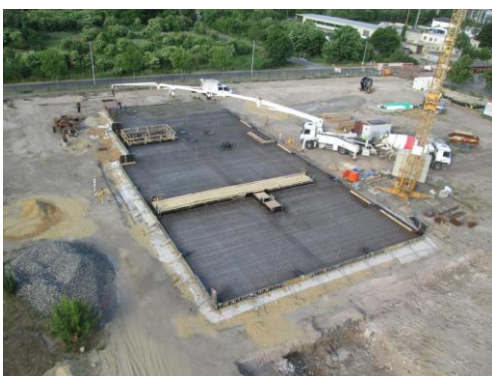
Abbildung 6: Beginn Betonierarbeiten Bodenplatte (Quelle: Th. Arens Anlagenbau GmbH)
